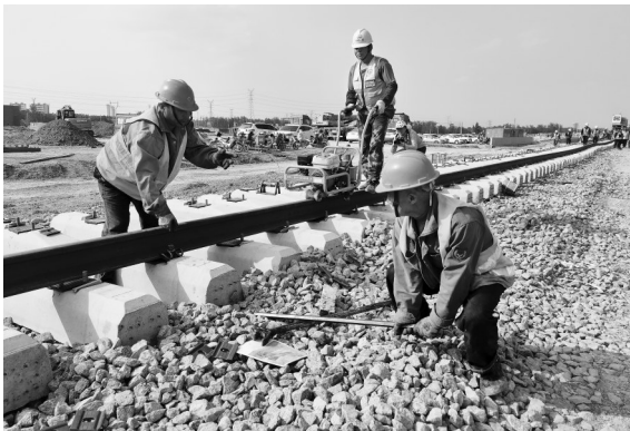
施工人员持各类工具辅助铺设轨道。
