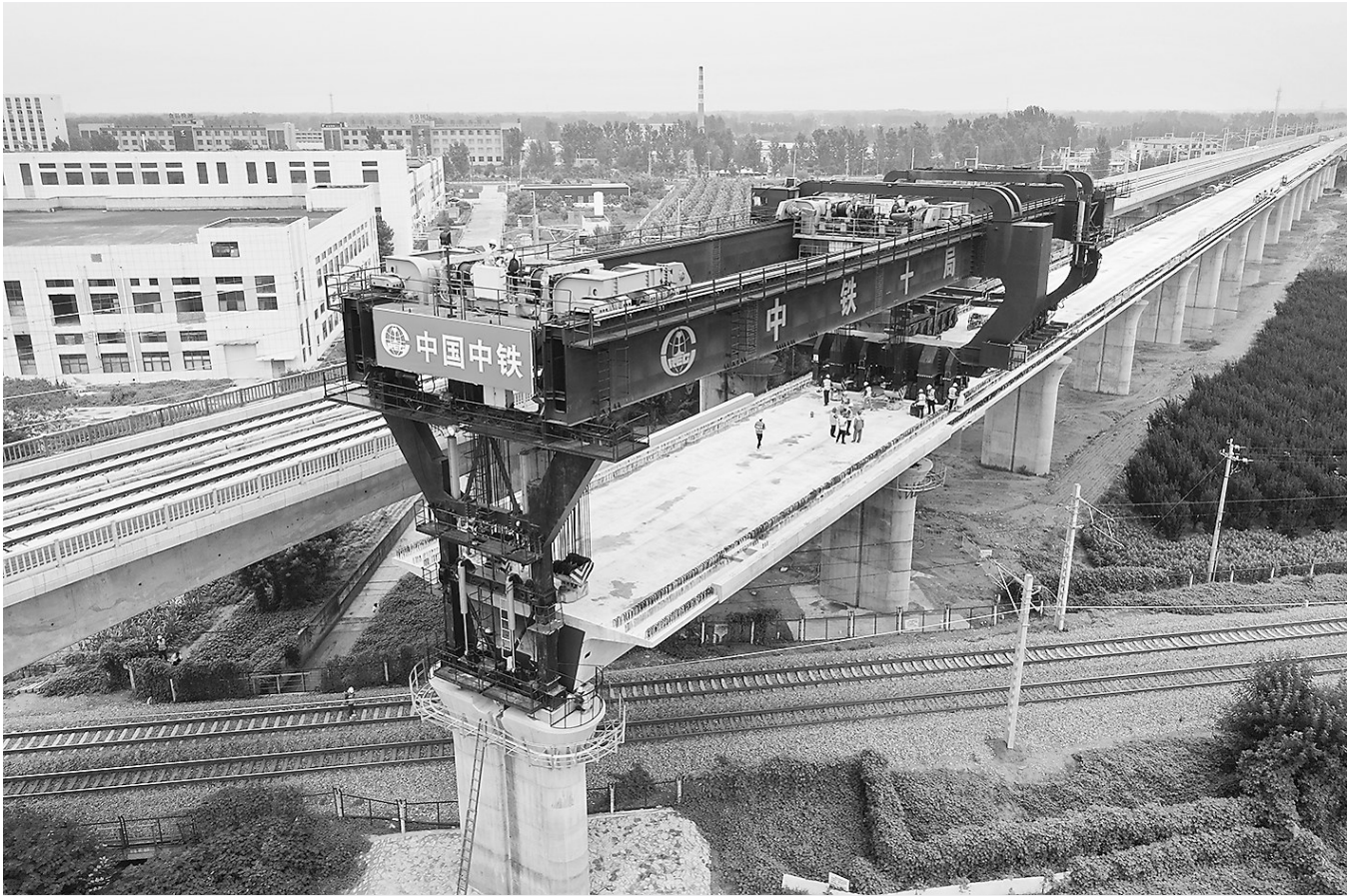
京雄商高铁上跨新兗铁路架梁施工现场
