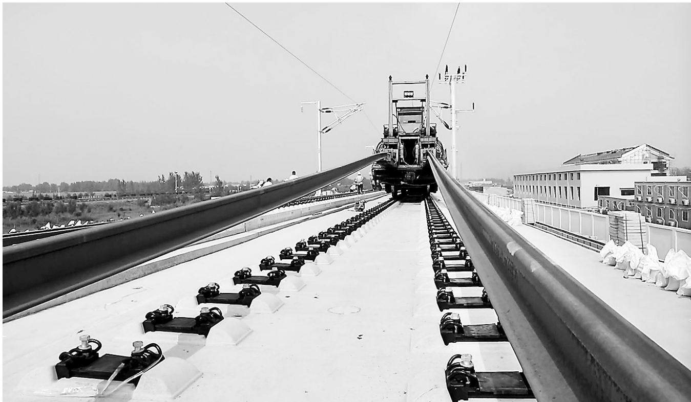
上图:鲁南高铁曲阜至菏泽至庄寨段正线最后一组钢轨铺设中。 下图:鲁南高铁庄寨站建设现场。
