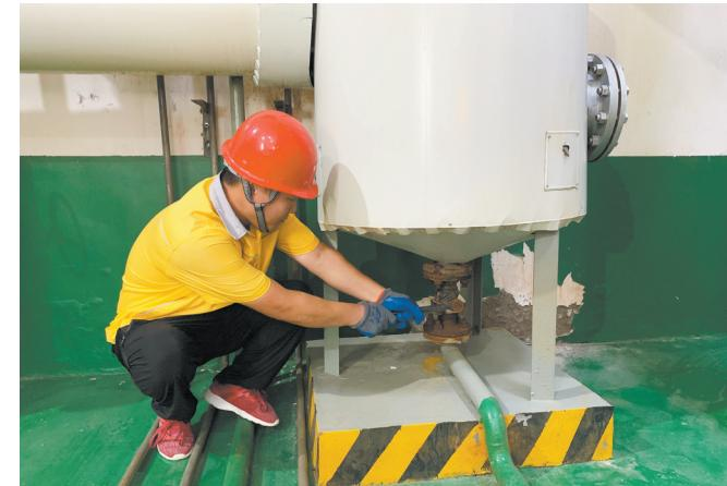
对所有的阀门进行了调试,检查其密封性和开关度能否满足要求。”梁超告诉牡丹晚报全媒体记者,通过逐项检查和检修,已经能够确保该小区换热站正常运行。
