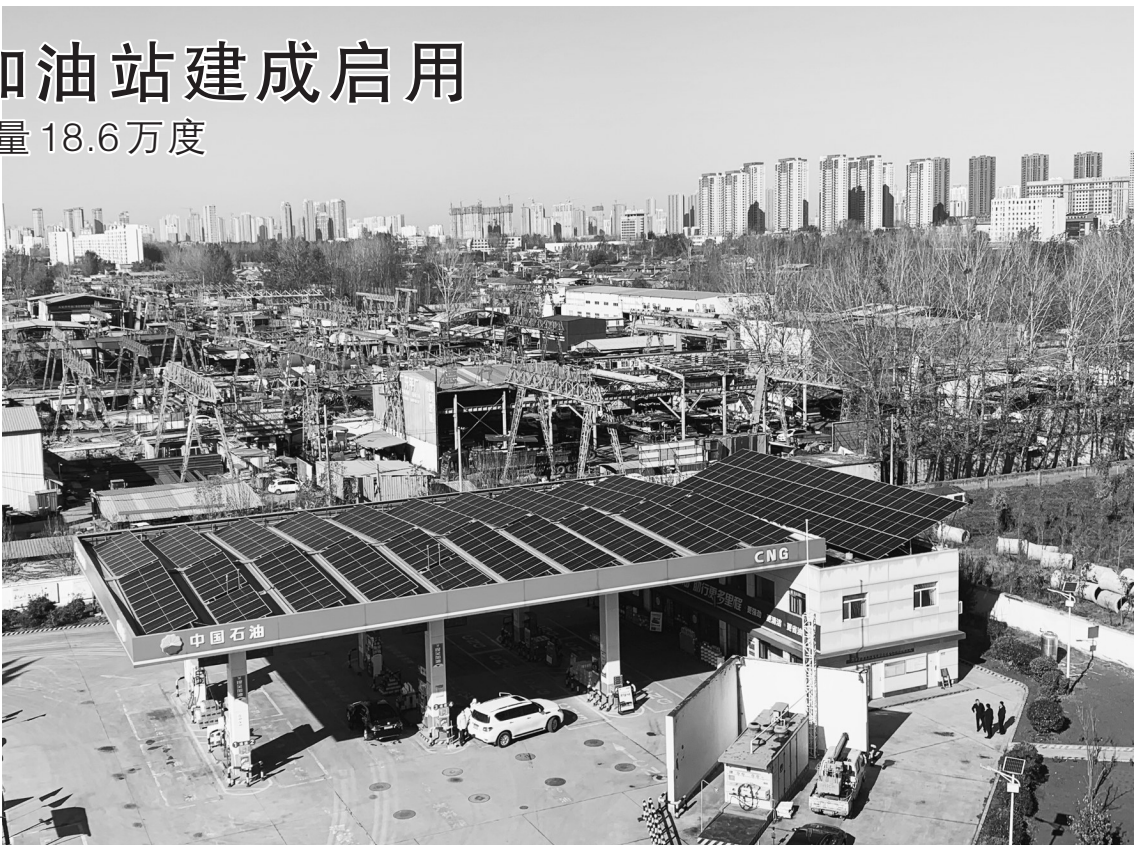
上图:工作人员按下光伏并网发电启动开关。 右图:位于市淮河路的我市首座光伏发电加油站,利用加油站罩棚顶、站房顶安装光伏太阳能发电系统。
