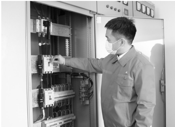
上图:工作人员按下光伏并网发电启动开关。 右图:位于市淮河路的我市首座光伏发电加油站,利用加油站罩棚顶、站房顶安装光伏太阳能发电系统。
