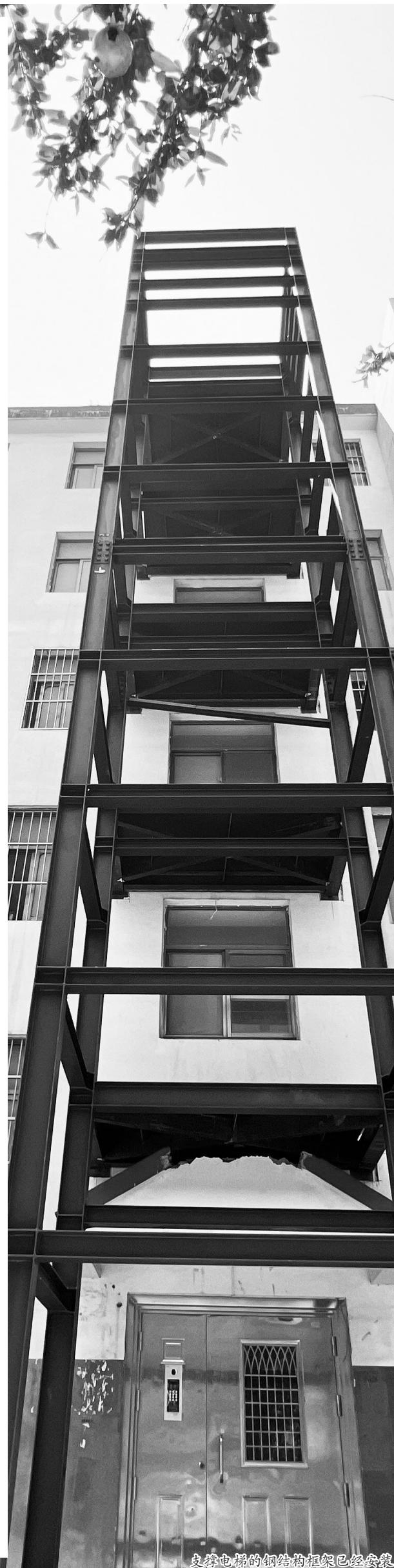
支撑电梯的钢结构框架已经安装
