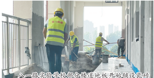
八一路实验学校部分楼道地板开始铺设瓷砖
