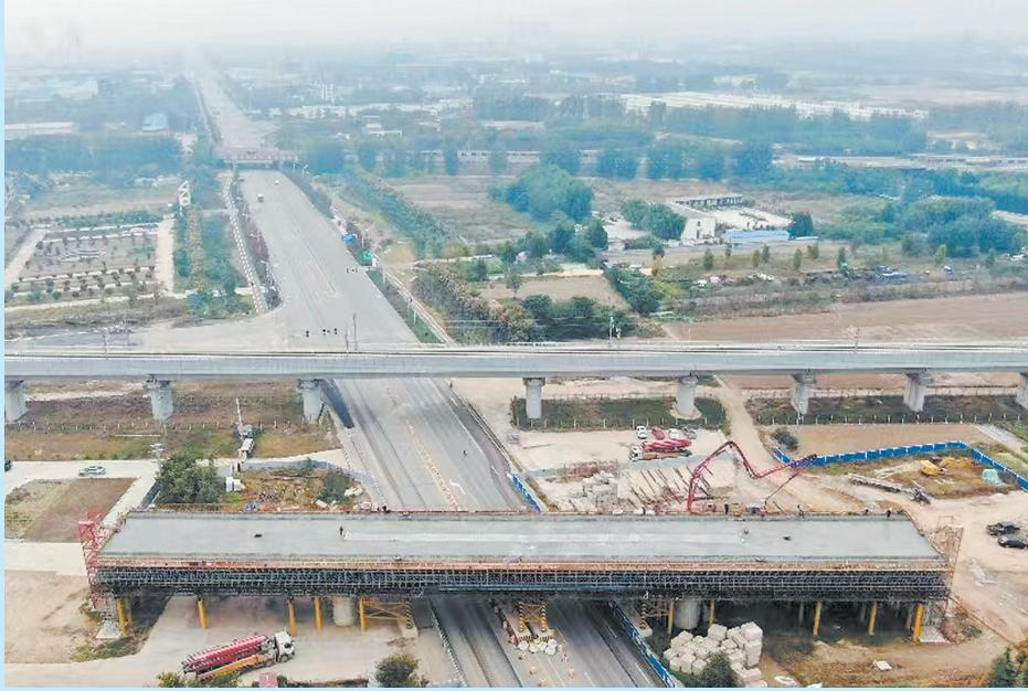
本报讯(牡丹晚报全媒体记者 胡云华 通讯员 张欣)10月19日,牡丹晚报全媒体记者从中铁十局雄商高铁并行段四分部获悉,雄商高铁并行段菏泽特大桥跨长江东路连续梁已经顺利浇筑完成,目前处于养护阶段。
