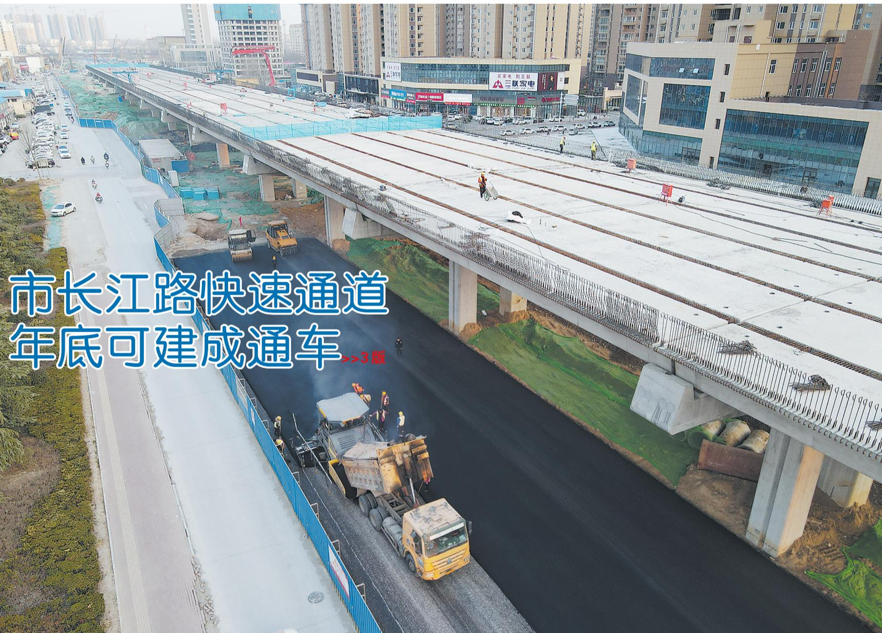
3月26日，市长江路快速通道工程一处施工现场，压路机、运料车来回穿梭，正在进行沥青混凝土路面铺装作业。
