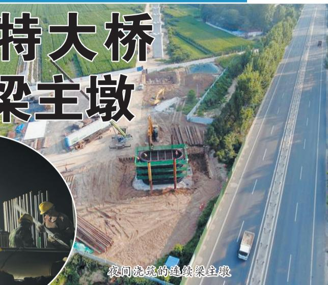
学组织、超前谋划,紧盯项目建设进度,高效推进项目建设。建设者们克服夏季高温墩身模板内闷热、空气不流通及钢筋密集振捣困难等困难,保证作业人员安全及墩身质量。主墩浇筑过程中,项目施工负责人全程在场盯控浇筑过程,严格控制混凝土配合比、坍落度,确保混凝土质量,并对连续梁墩身各个关键工序、控制要点进行严格卡控,把好每道工序的安全质量关。
