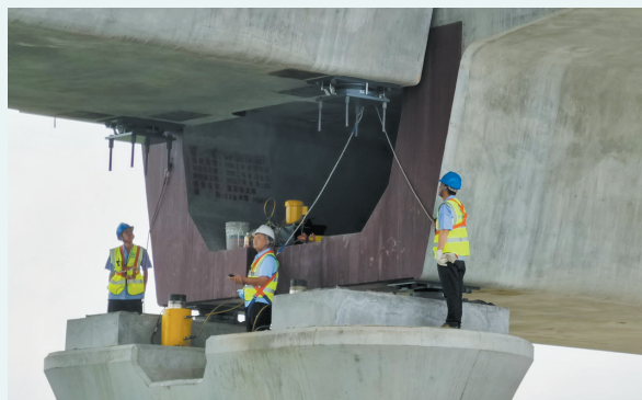
▲▼雄商高铁菏泽段箱梁架设现场。
