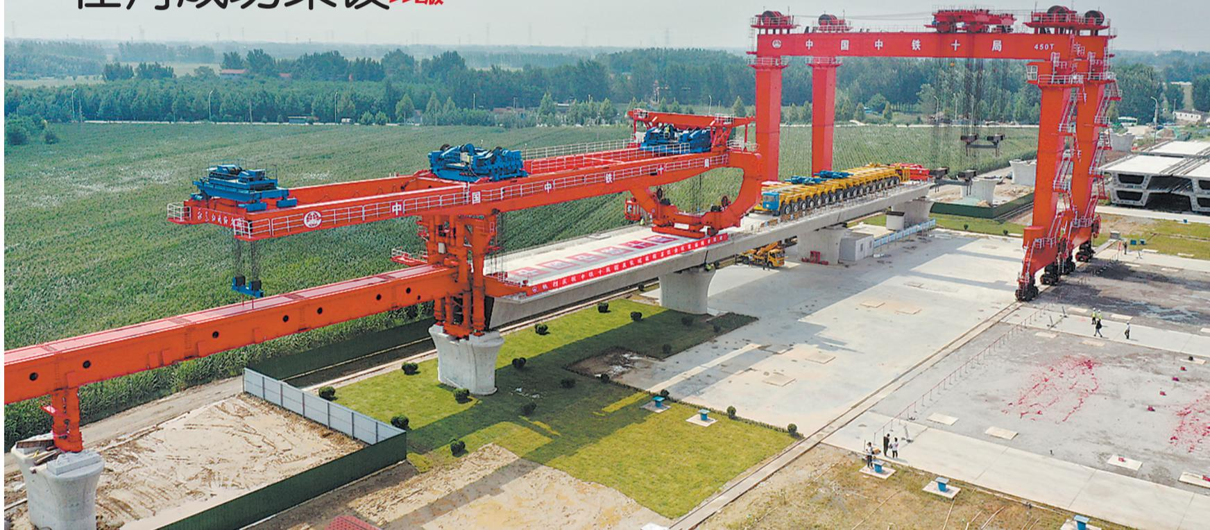
8月28日10时40分,随着架运一体机将长32.6米、宽12.6米、高3.015米、重量725吨的箱梁架设在菏泽特大桥238~239号墩位,新建雄商高铁全线首
