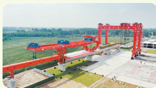
雄商高铁菏泽段箱梁架设现场。
