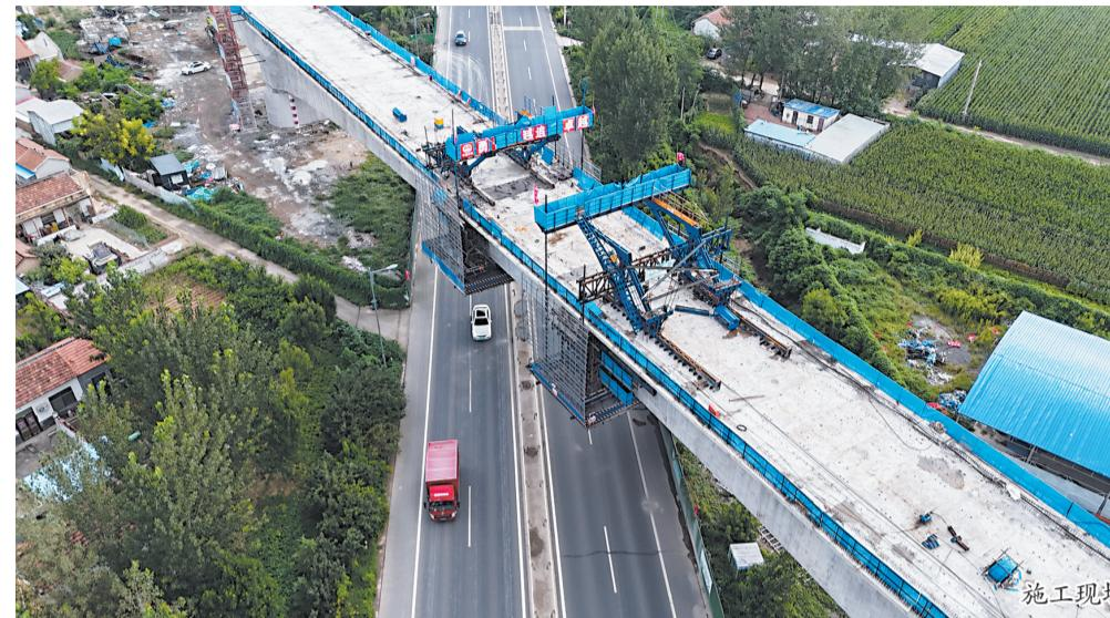
菏泽特大桥跨G220连续梁位于菏泽市郓城县,桥梁跨度大、工艺复杂,施工周期长。跨越既有国道、车流量大,干扰因素多,施工对G220既有交通有一定影响,施工安全风险
