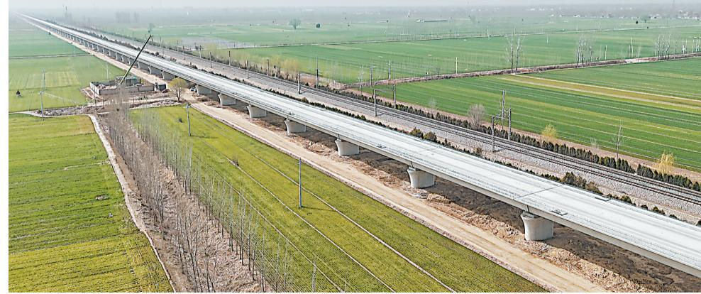
本报讯(牡丹晚报全媒体记者 胡云华) 3月17日,雄商高铁梁山至郓城段施工现场呈现出一派繁忙景象。从中铁十局雄商高铁梁郓项目部获悉,目前雄商高铁郓城段路基工程已全部完工,正在进行堆载预压,待沉降评估完成后将正式进入无砟轨道铺设准备阶段。
