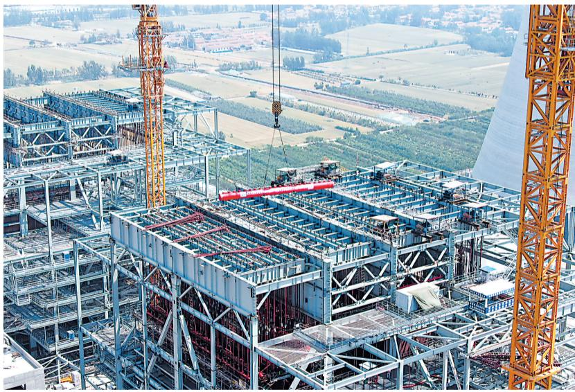
本报讯(牡丹晚报全媒体记者 姜培军) 5月20日,在大唐郓城630℃国家电力示范项目建设现场(上图),随着指挥员一声令下,重达14吨的“二次高温再热器集箱”缓缓吊起,并在精准操控下平稳就位。全球首个采用国产马氏体耐热钢(G115®钢)制造的机组设备成功吊装,标志着我国自主研制的G115®钢首次实现工程化应用。
