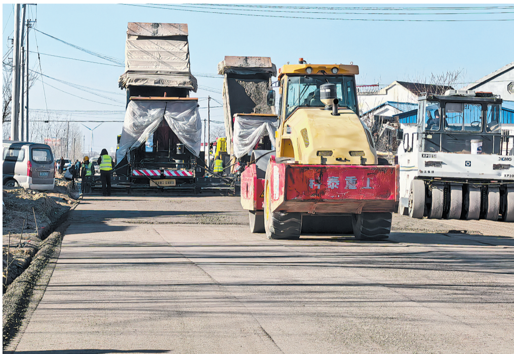
▲▼鄄城沿黄公路施工现场。
